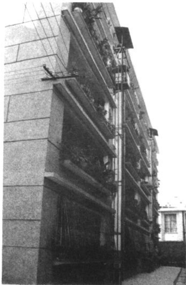
玉溪檢察分院新建住宅
