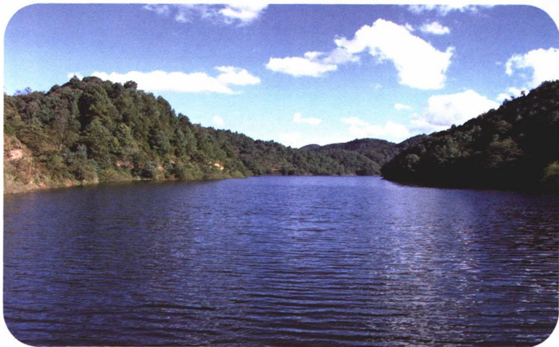
县城供水水源——大龙潭水库(丰水期)
