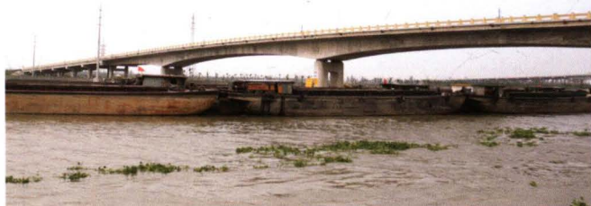
松蒸路斜塘高架浮桥拆除后新建的公路桥
