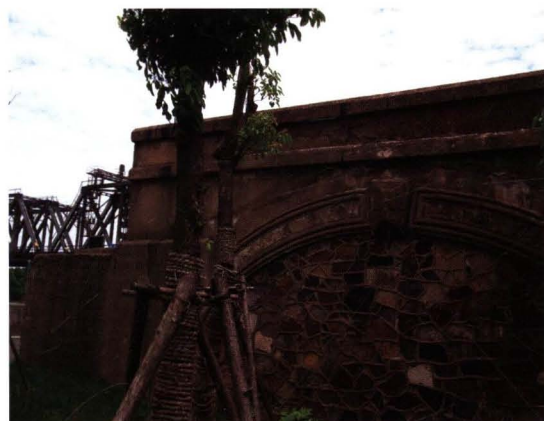
沪杭铁路老桥墩（1908年建）
