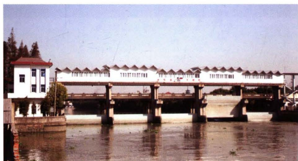
油墩港节制闸
