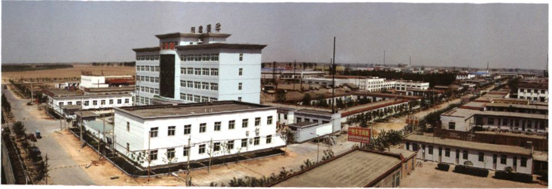
留各庄保温建材工业园区
