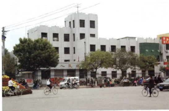
人民银行办公楼
