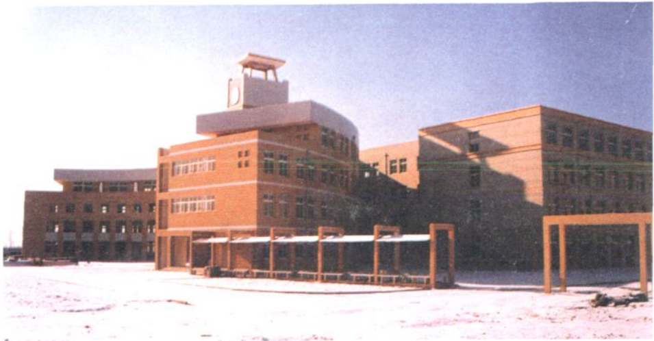
新校舍办公楼侧面
