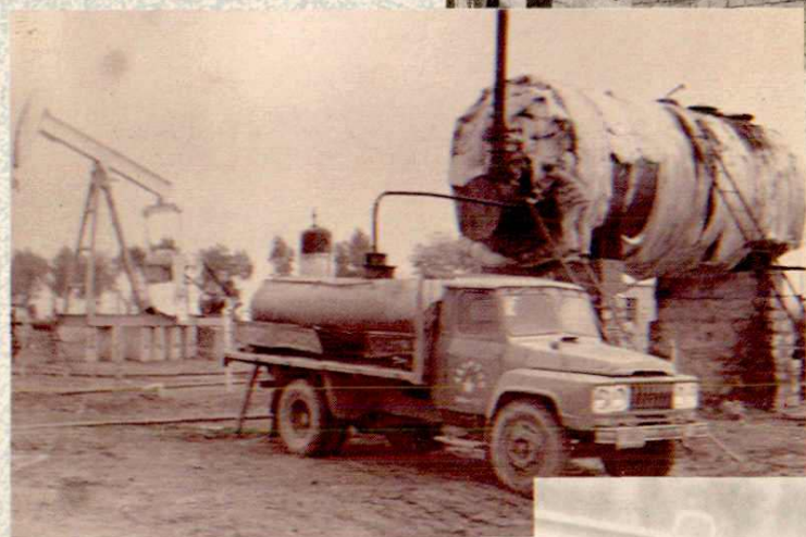
朝阳沟油田第一车原油外运
