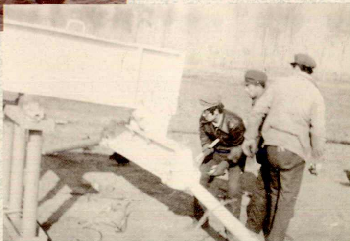
第一口机械采油井安装现场
