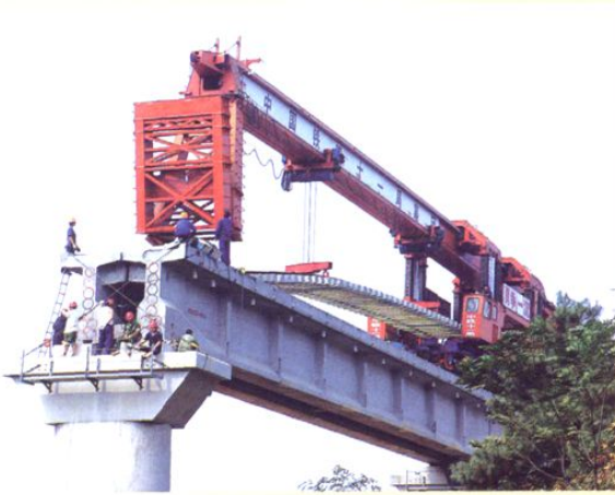
铺架机在铺轨
