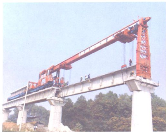
铺架机在架梁
