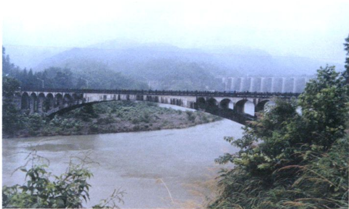
安徽省第一座公路特大桥——佛子岭桥
