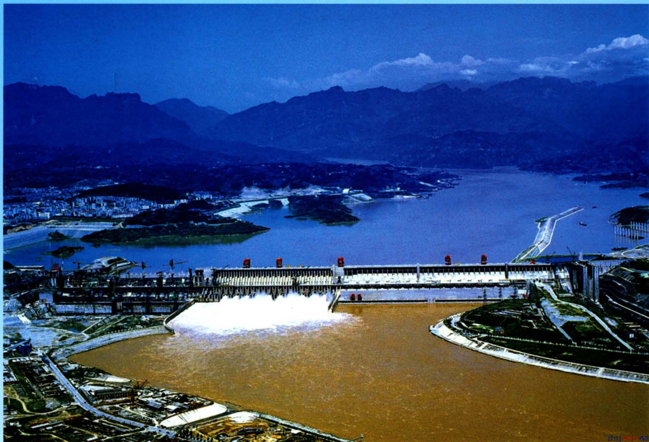
中国当代大型水利工程——三峡大坝
