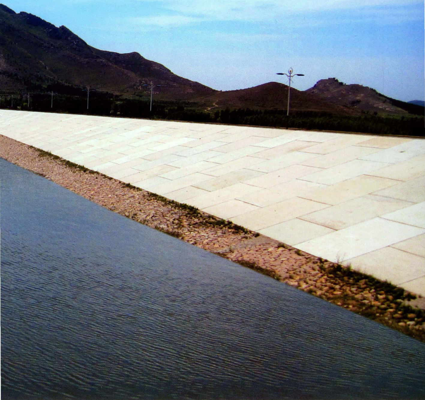
白山水库全景
