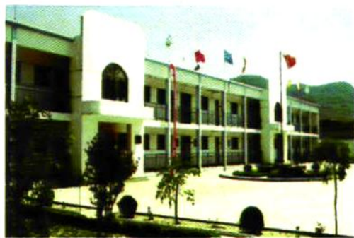
新建西闫中学教学大楼
