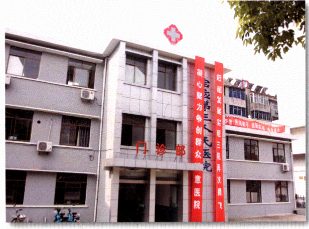
2007年县第三人民医院门诊楼
