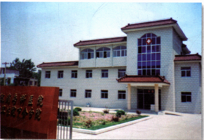
2000年下舍乡卫生院门诊楼
