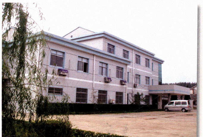
2004年沿河镇卫生院门诊楼
