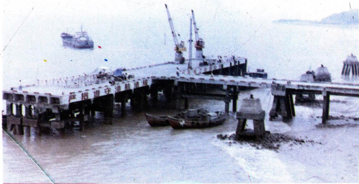
玉环大麦屿港 1000 吨级码头
