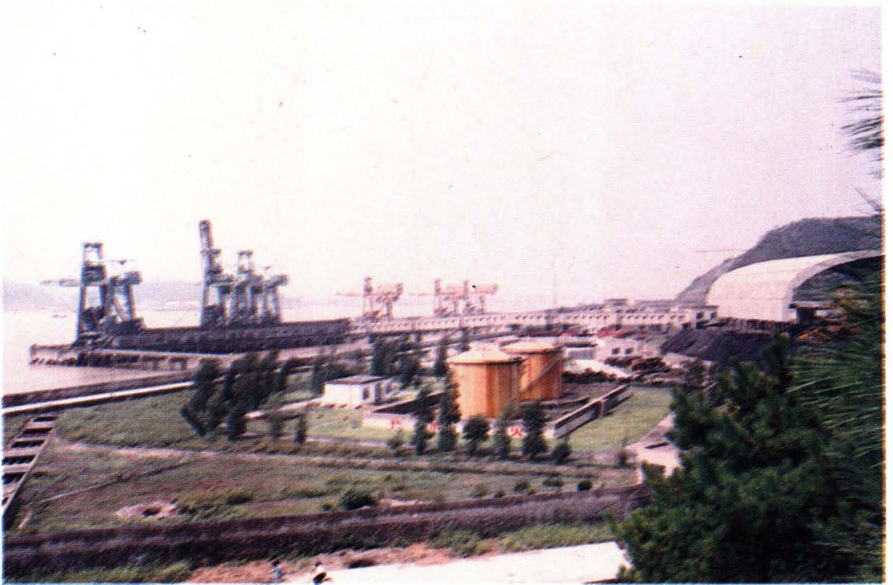
椒江海门港前所港区台州电厂 10000 吨级码头
