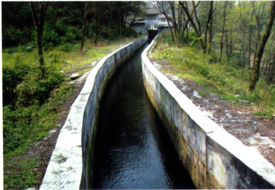
钟灵水库总干渠
