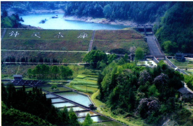
钟灵水库全貌
