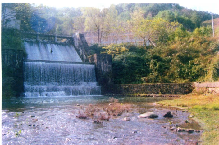
钟灵水库放水隧洞 出口挑流段
