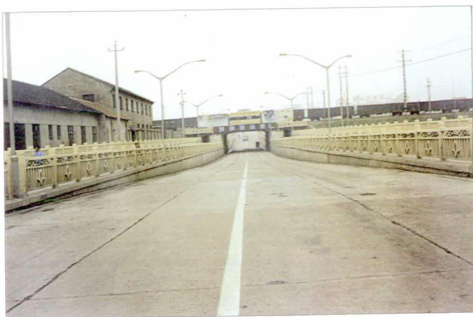
城东铁路公立交桥
