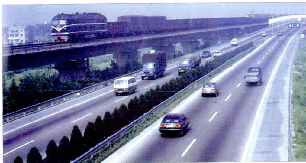
钱江二桥萧山岸的铁路（浙赣绕行线）公路（杭甬高速公路）接线
