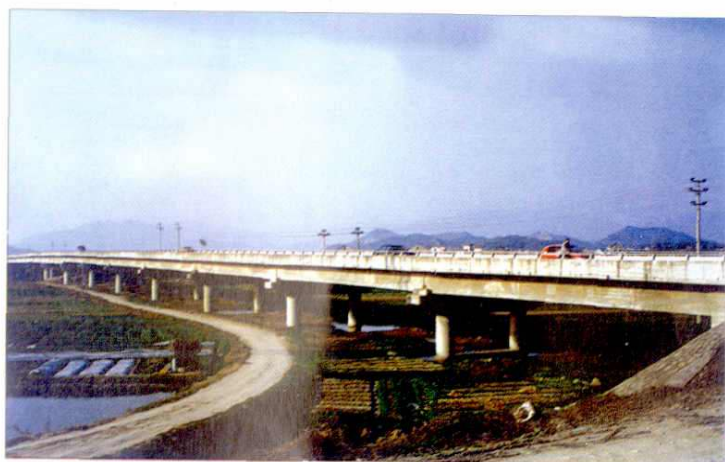
临浦·二桥引桥
