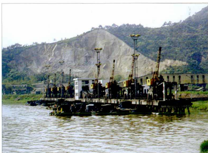
萧山电厂煤炭专用码头
