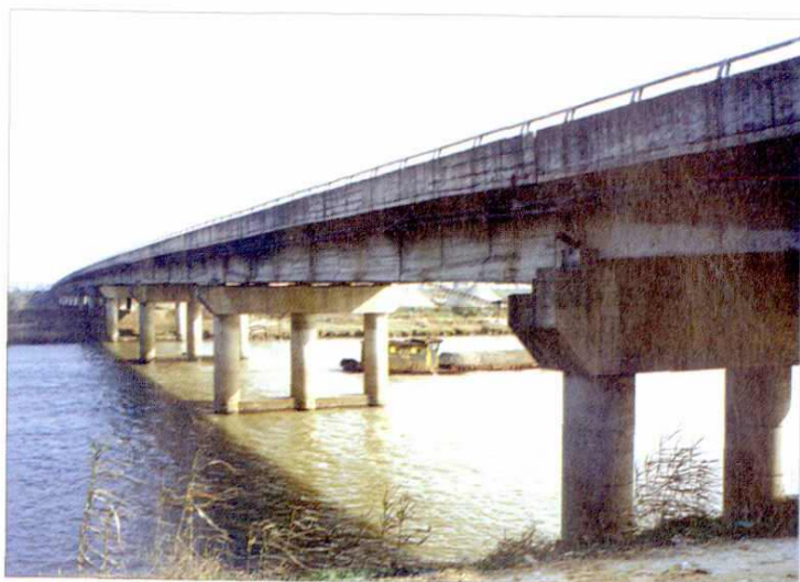
临浦·二桥主桥
