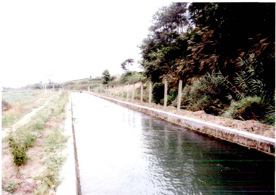
南山水库灌区渠系
