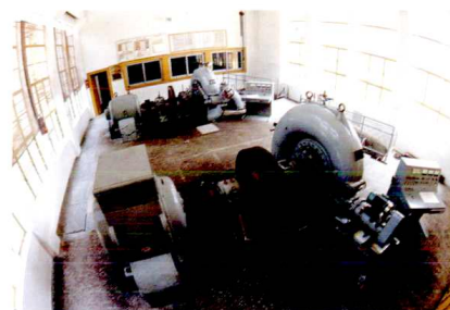
坂头水库电站水轮发电机组
