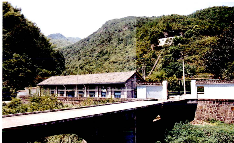
镇基山电站（三溪江流域梯级电站）
