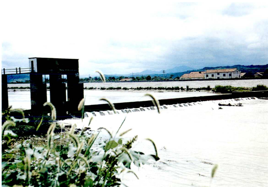
黄泽江后官桥碛（水力自控多铰钢筋混凝土肋形翻板门）
