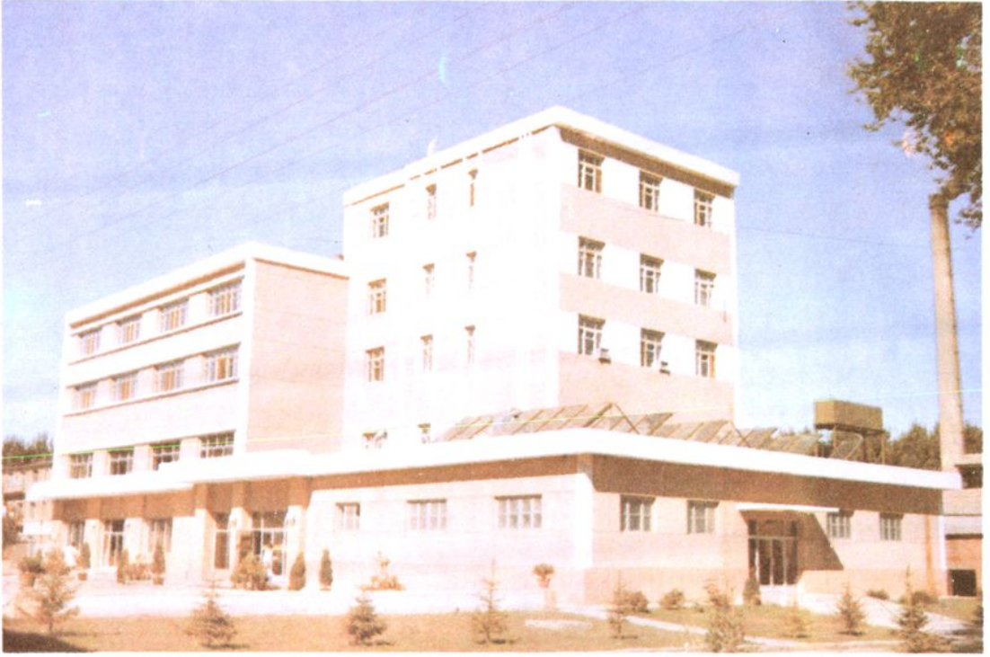
服务中心大楼
