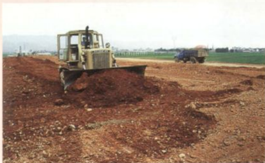
正在兴建的新昆石高速公路
