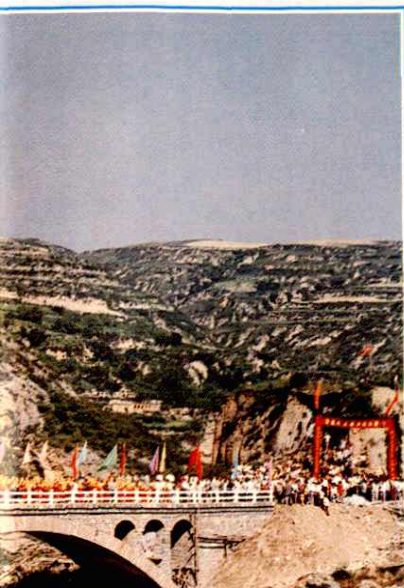
▲郭家店公路大桥
