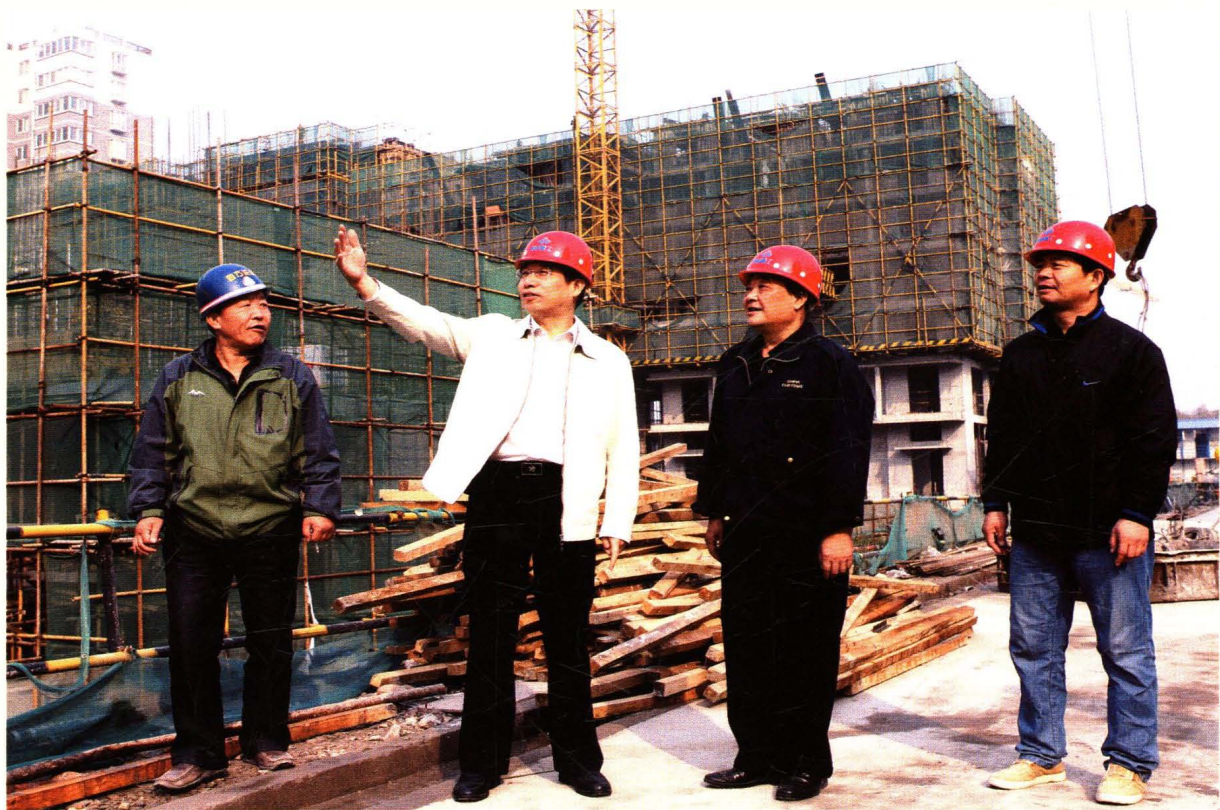
2013 年 10 月西安海关关长徐蔚葳（左二）在团购房项目工地现场检查施工进度情况
