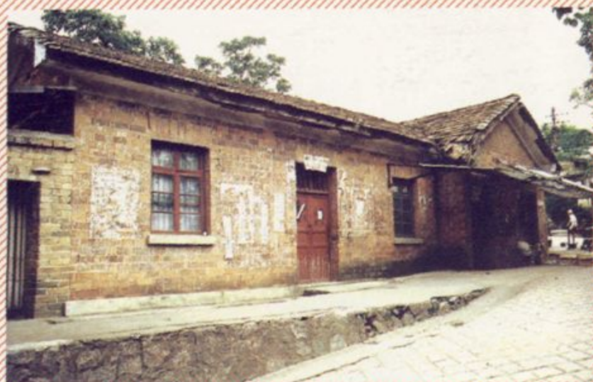
汀家畈邮电所旧址
