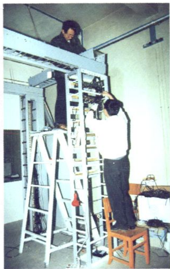
机务员正在对设备进行认真维护和调测。
