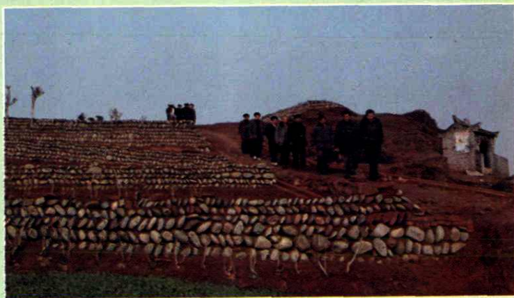
▼ 长治工程东塔油房沟小流域水土保持坡改梯现场。
