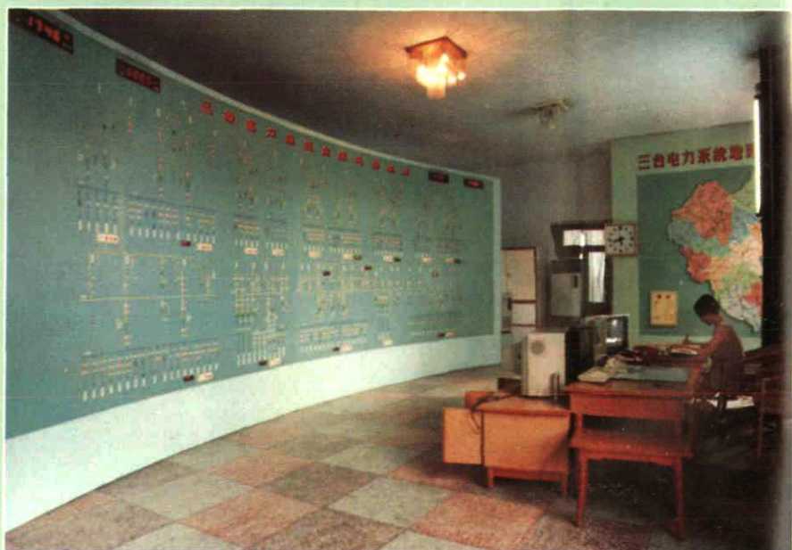
►三台县电力调度所调度室。
