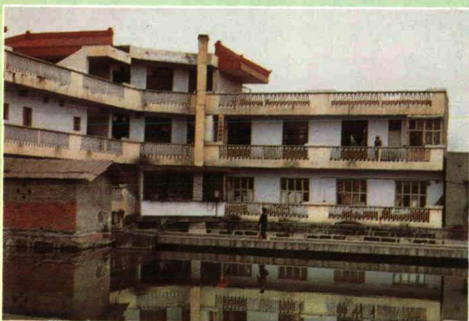
▲ 三台县鱼种站办公、营业综合楼和鱼种池。
