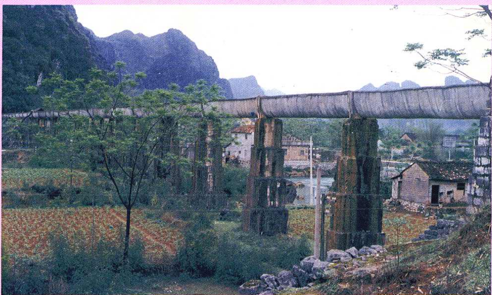
澄江水利工程福常渡槽
