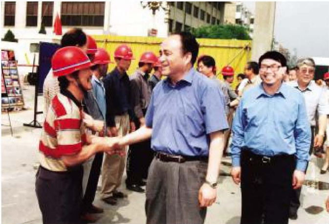
1999年5月,自治区党委书记毛如柏(右二)在地勘局局长严烈宏(右一)的陪同下,到银川市南门人防工程施工现场看望地质工程技术人员
