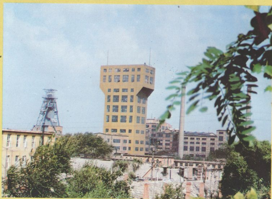
抚顺龙凤矿竖井井塔
