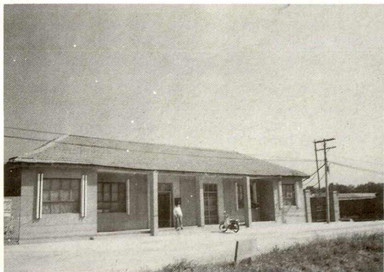
进行破旧小改 造后的孙庄邮 电支局
