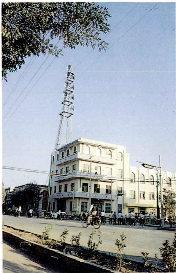
县邮电局综合通信楼
