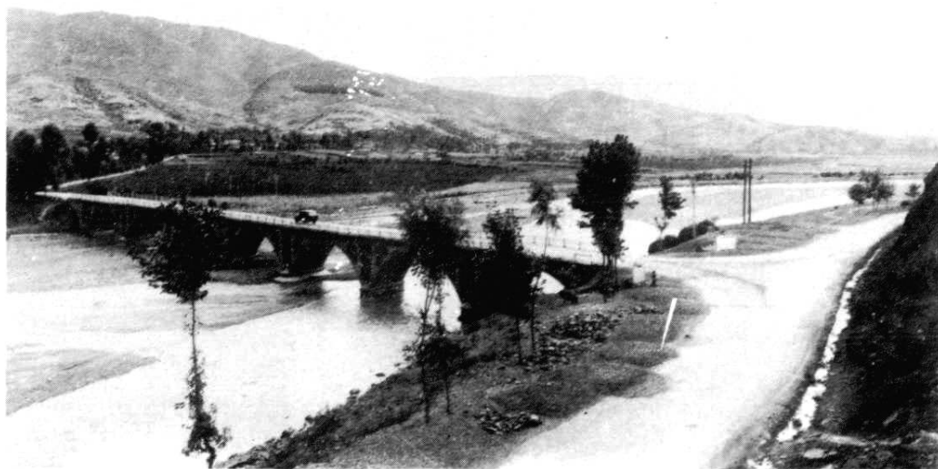
三湾河桥，位于宜西公路与普(格)三(湾河)公路交会处。
