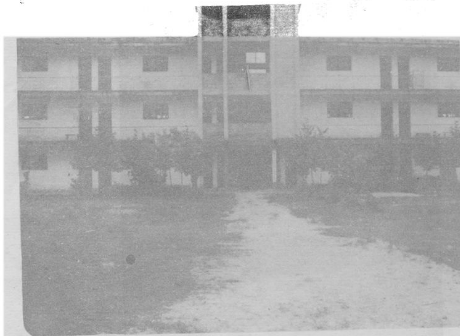
铁门岗农业高中教学大楼
