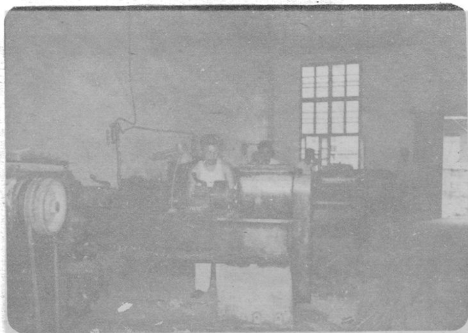
铁门铸钢厂精加工车间
