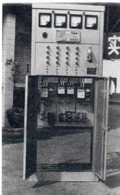
← 五金厂电源功率自动补偿屏
