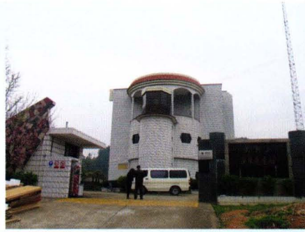
▲ 110千伏溪东变电站
