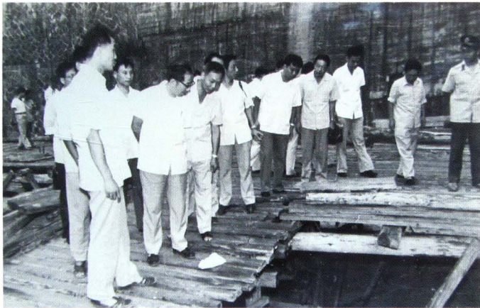
1985年8月5日，省长胡平（左前二）考察东溪水库电站工地。
