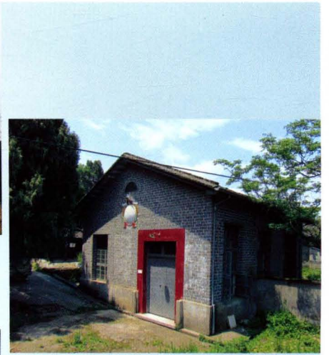
▲ 第一座县办水电站——西溪电站
