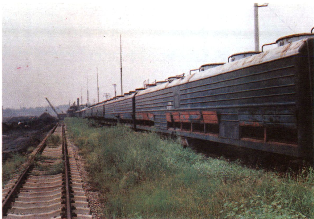
6000 千瓦列车电站外景
