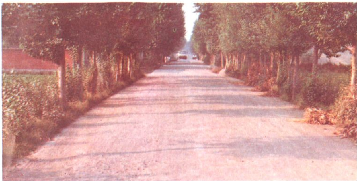
好生至临池公路粒料路面
