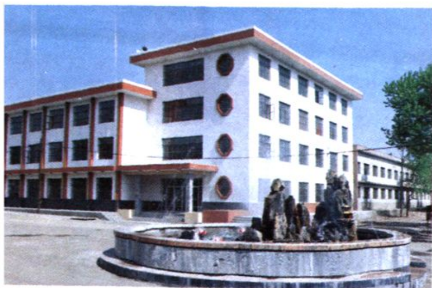
◀吉林铝业公司综合检测楼
