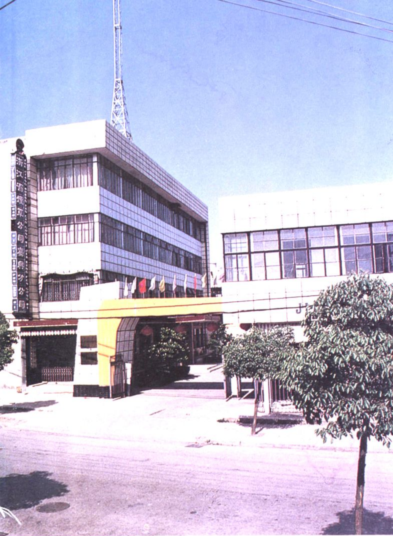
浙江省嘉兴市烟草专卖局、浙江省烟草公司嘉兴分公司办公楼(嘉兴市吉水路)
