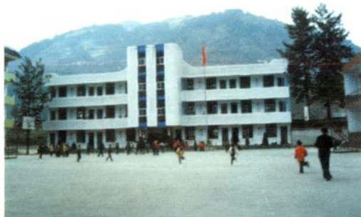
安顺场八一希望小学教学楼
