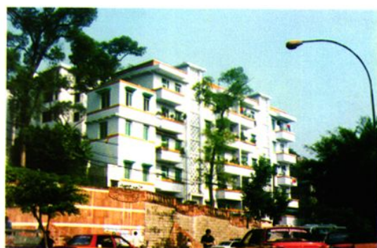
2号配气站及宿舍楼
