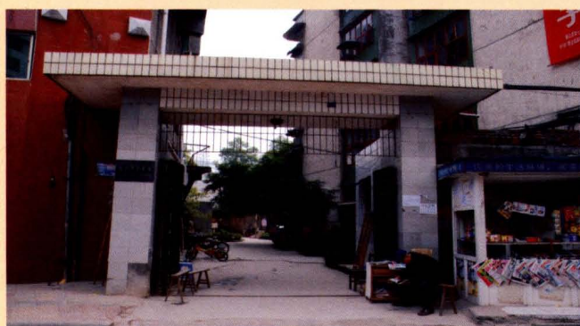
原工业局办公楼
