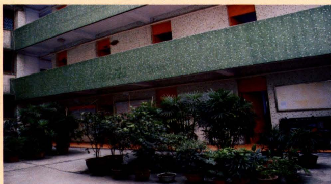
原煤炭工业公司办公楼
