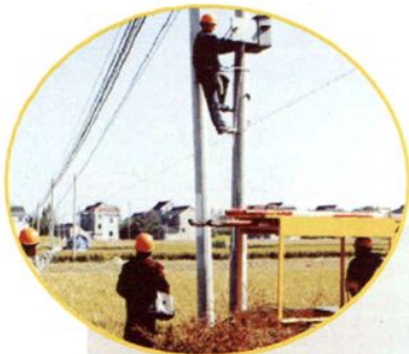
◀ 工人在架设广电光缆
