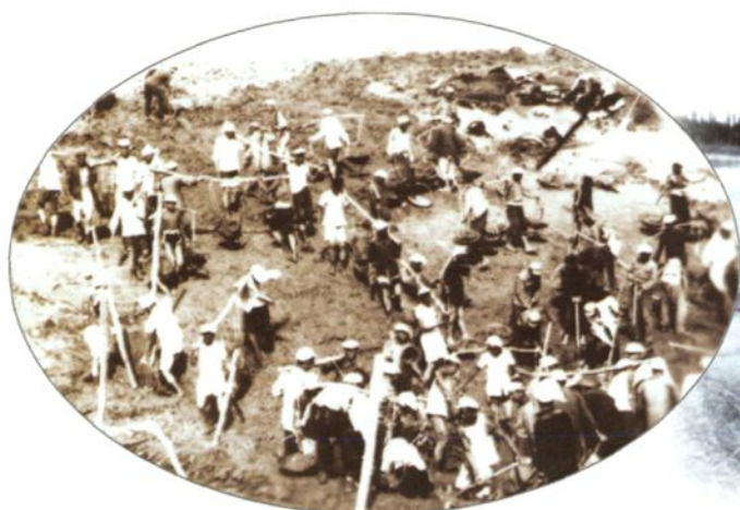
民工开挖总干渠施工现场
