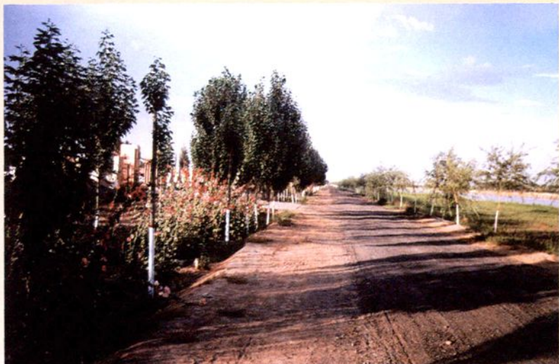
总干渠标准化渠堤
