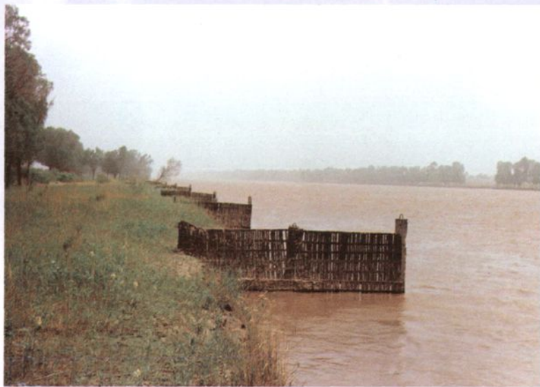
总干渠冲桩挂笆维护工程
