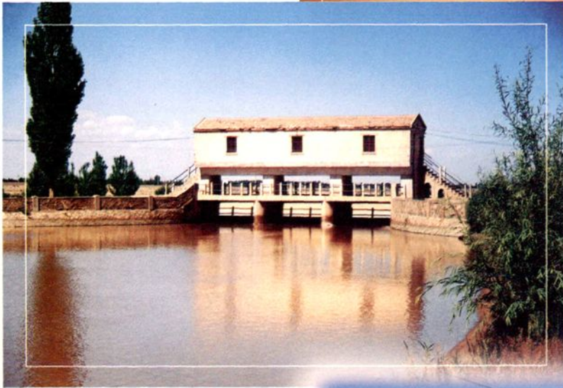
总干渠第三分水枢纽
