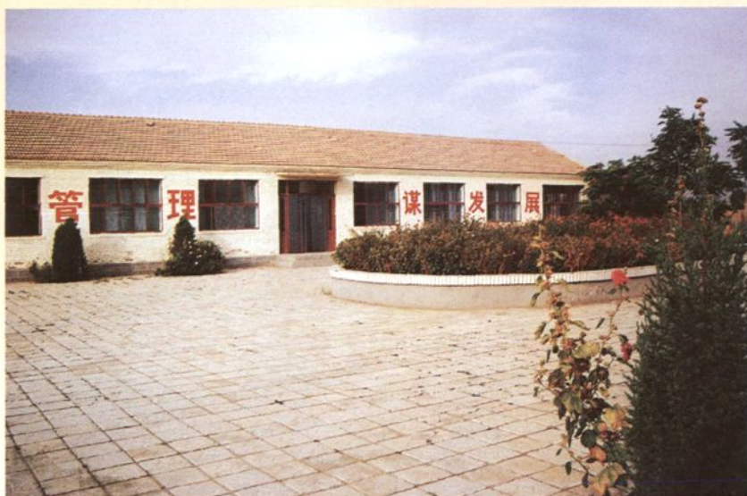
总干渠第五管理所
