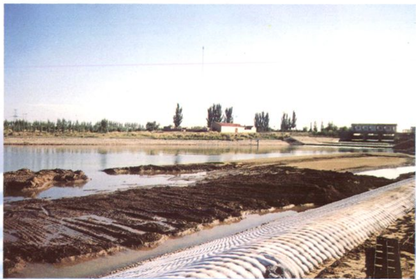
总干渠二闸膜袋护砌工程
