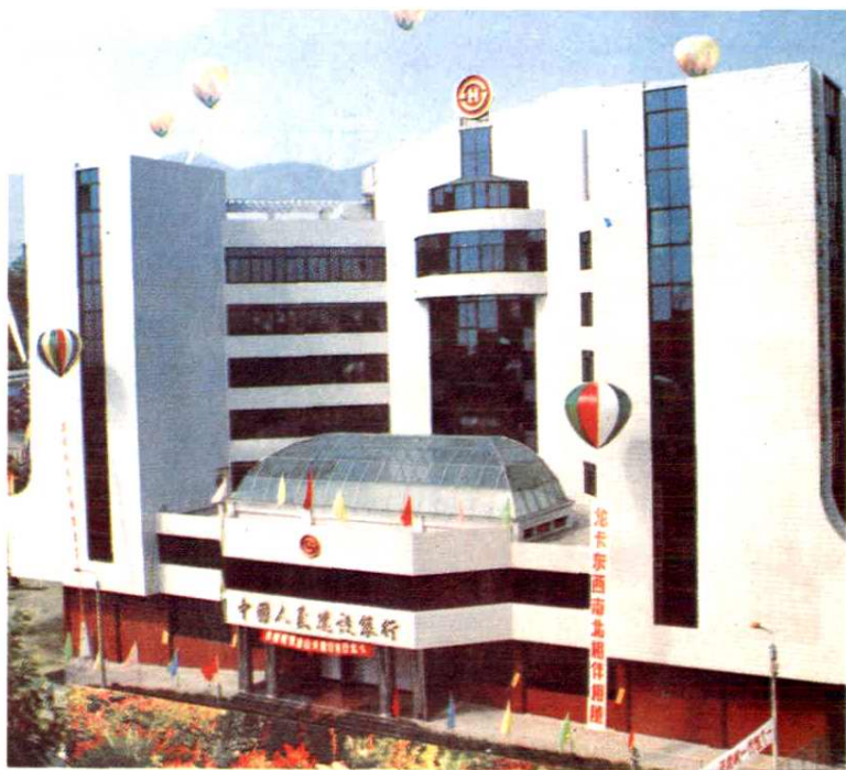
▶中国人民建设银行凉山彝族自治州分行办公楼 地址：西昌市文汇巷3号
