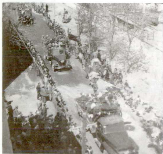
欢送修渠民工
