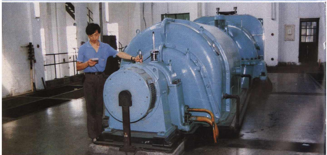
自行设计、安装的 12 兆瓦汽轮发电机组
