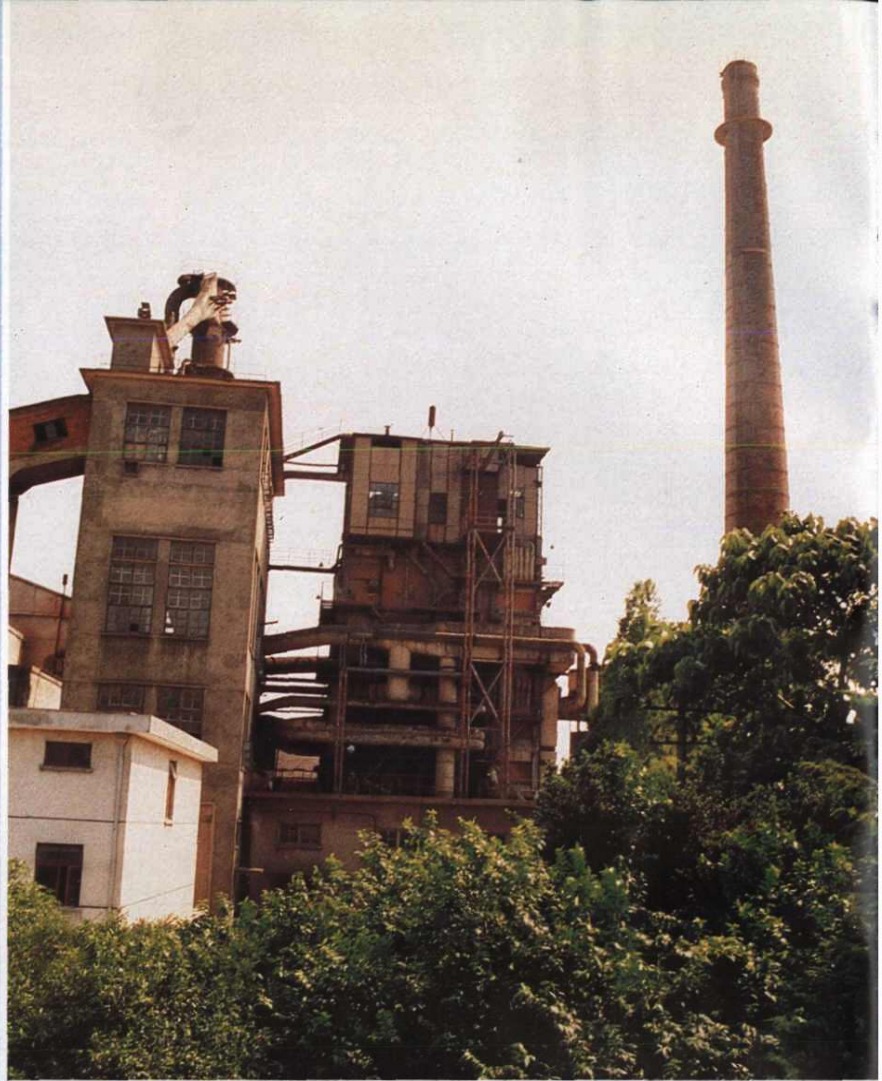
自行设计、制造、安装 的 65 吨/时锅炉
