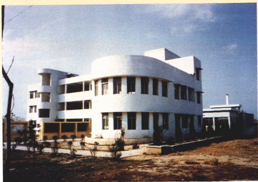
亭桥乡中心小学教学楼
