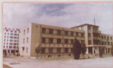
▲ 奈曼旗人民医院住院楼
