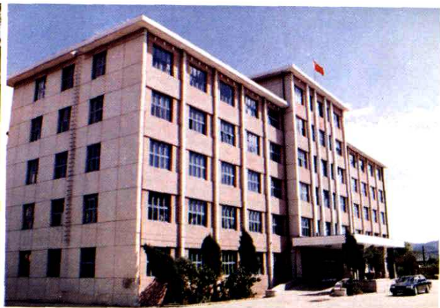
市政府办公楼
