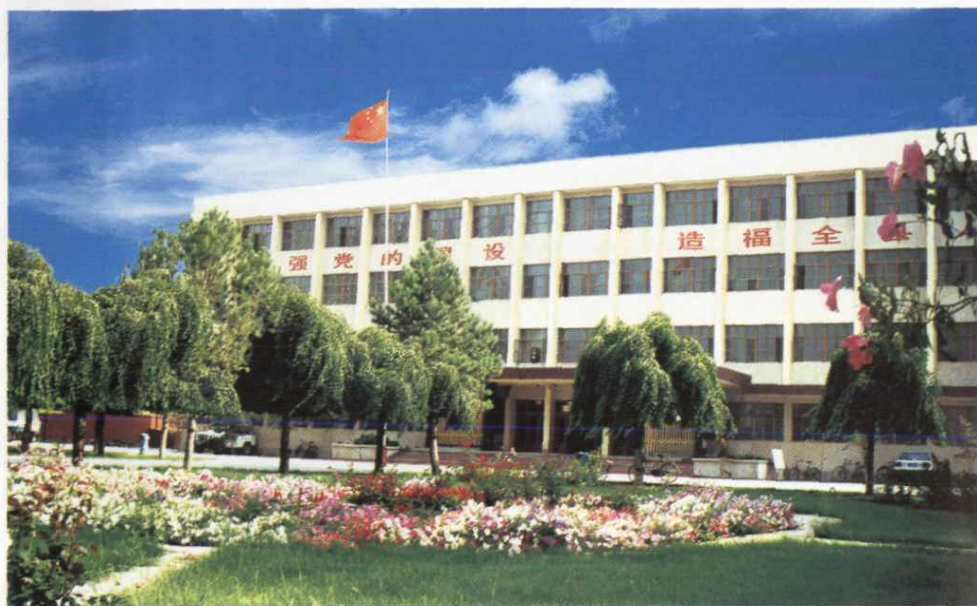
△ 中共裕民县委办公楼
