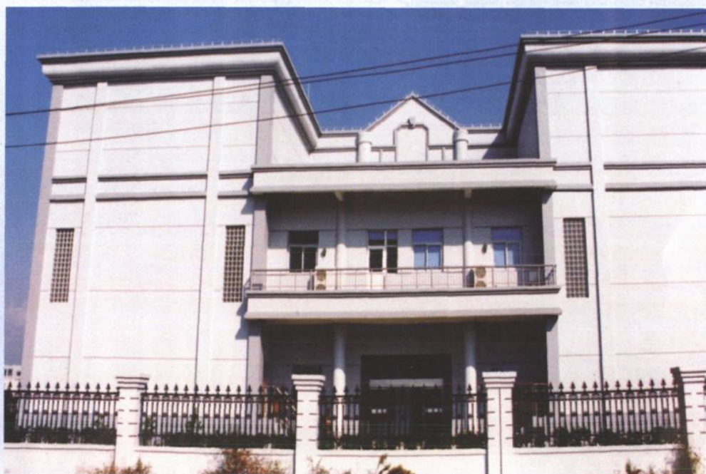
110 千伏城北变电所
