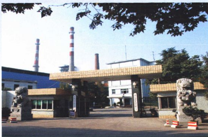
浙江嵊州新中港热电厂门景
