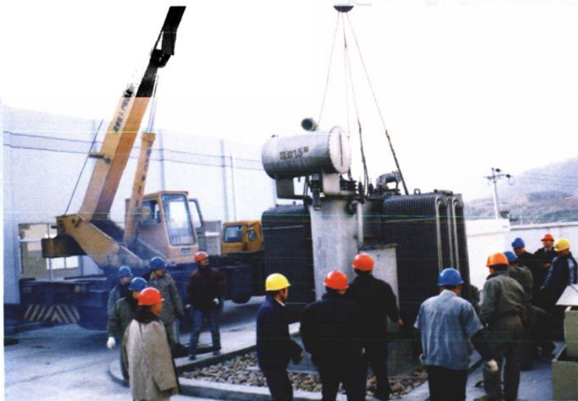
2003 年 12 月 16 日，35 千伏北山变电所主变压器吊装
