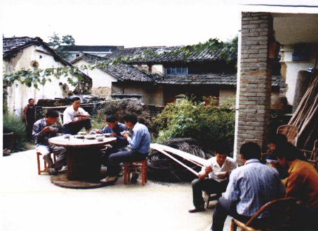
自办伙食在施工现场就餐
