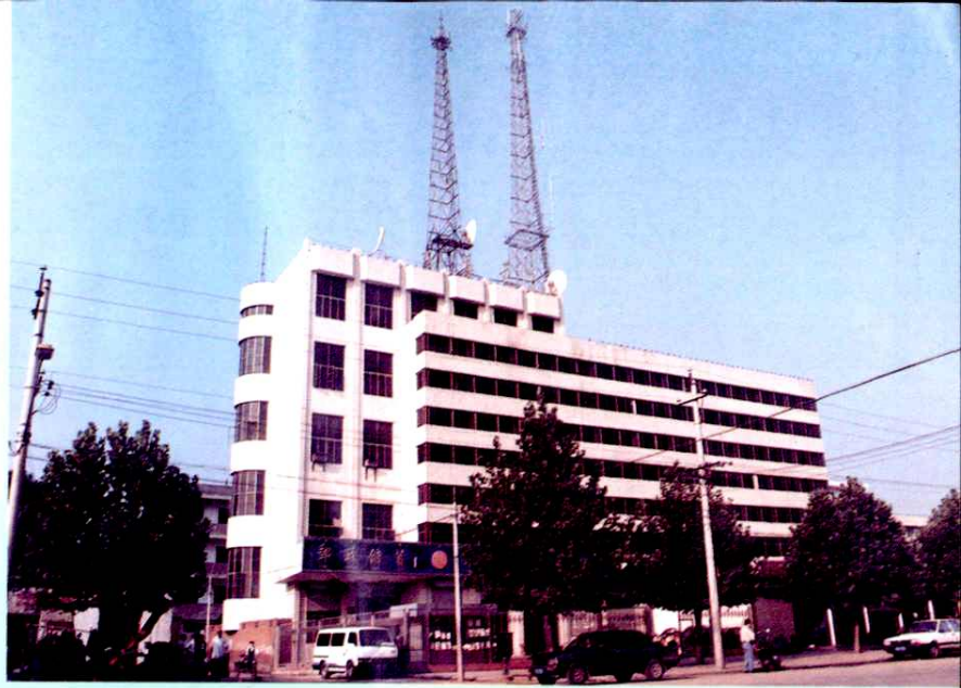
中心路电信楼
