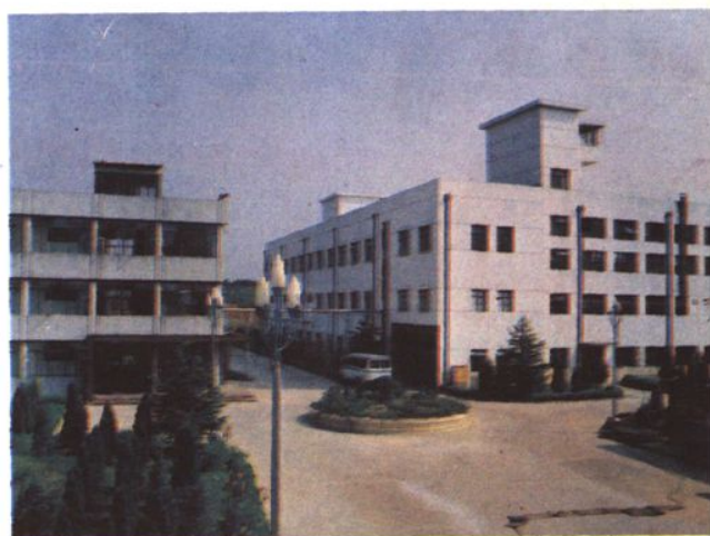
饮片厂生产车间外景
