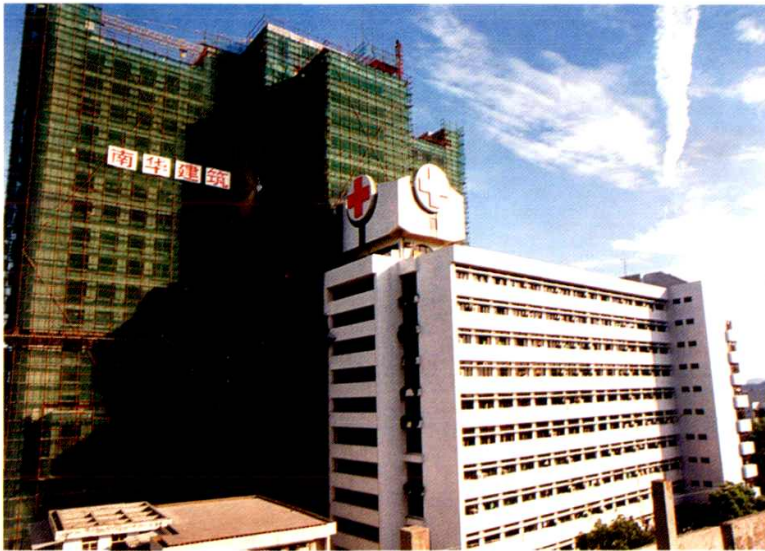
12层综合住院大楼与即将竣工的21层住院大楼
