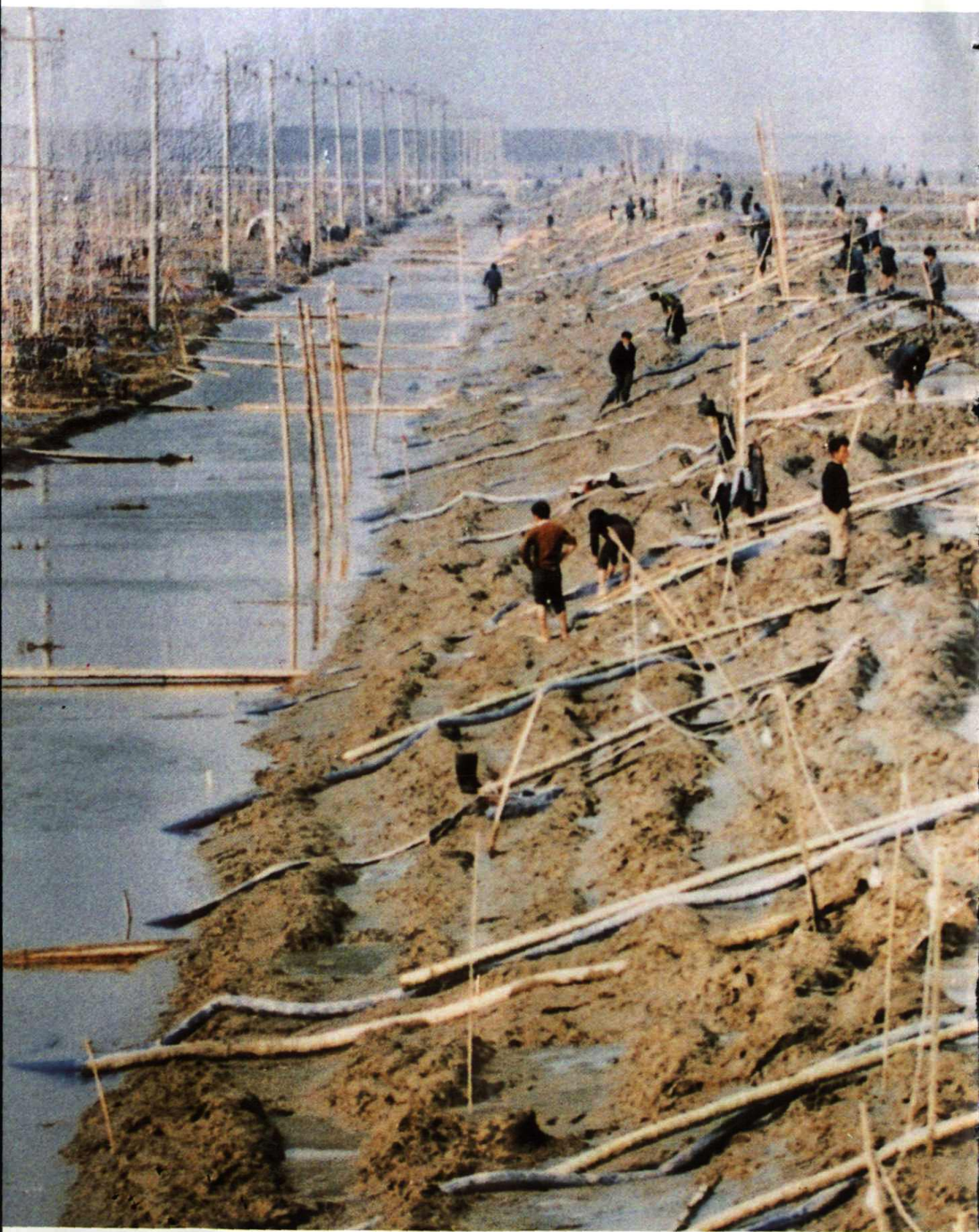
以泥浆泵为主的机械化围涂
